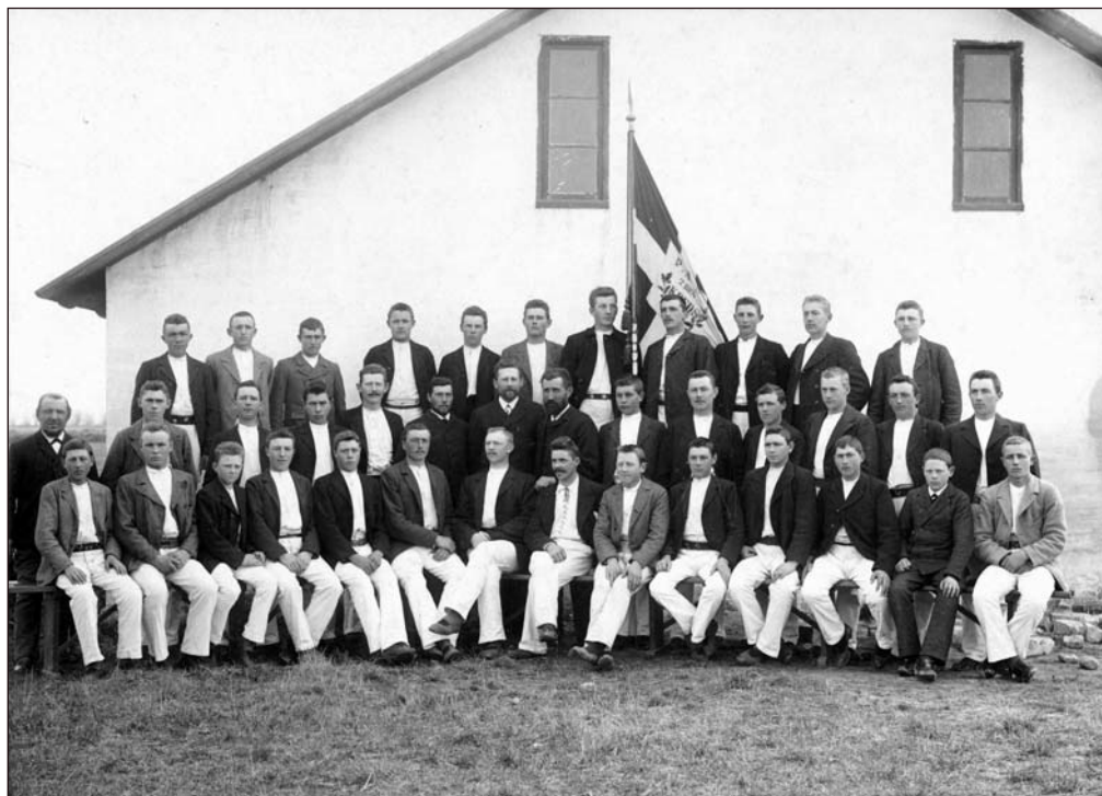
Gymnaster ved „Øvelsehuset“ ved Asylet Trommeslagervej (fattiggården). Sognets første forsamlingshus. Bygget 1881 og ophørt 1917.
